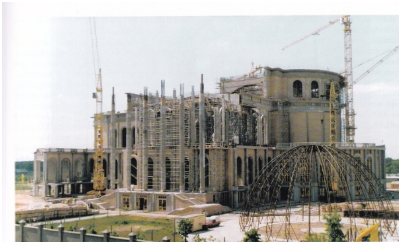
Północno-wschodnia strona budowanej bazyliki. Stan z czerwca 1998 roku
